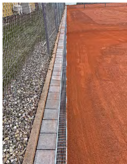
Stirnseitige Entwässerungsrinne, durch Pflasterstreifen vom Tiefbord getrennt
