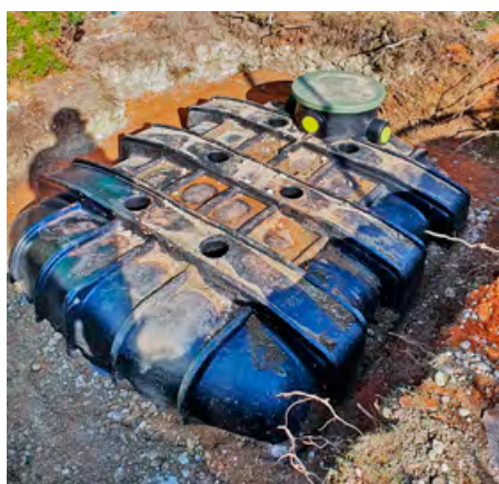
Unterirdischer Flachtank zur Rohrnetztrennung mit freiem Frischwasser-Zulauf
