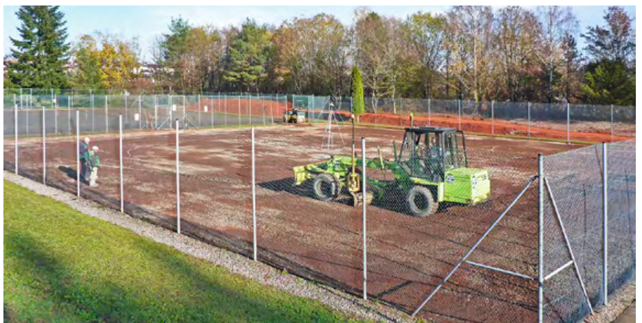
Einbringen der neuen Lava-Schicht und Geländemodellierung mit Tribünenbau im Winter (Bild unten)
