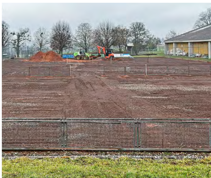
Abtragen des verschlissenen Materials an Platz 1–3
