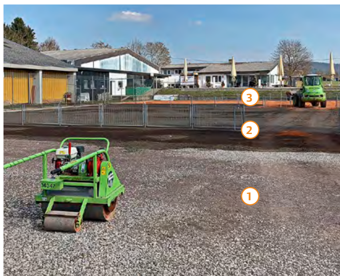
Neuer Aufbau mit 1) Schotterplanum | 2) Dynamische Lavaschicht | 3) Ziegelmehl-Deckschichten
