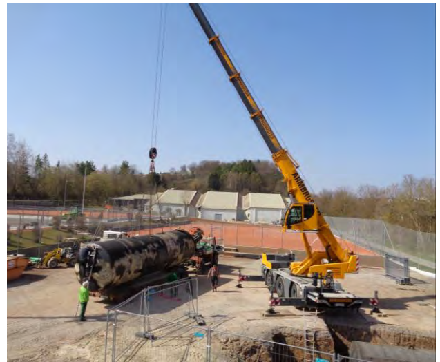
Bei der Umgestaltung ihrer Tennisanlage hat die TA SV Holzgerlingen einen ausrangierten Tank als Zisterne für die Platzbewässerung verbaut.
