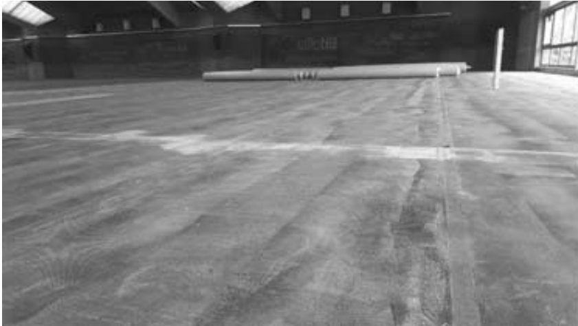
Vorbereitung zur Montage
